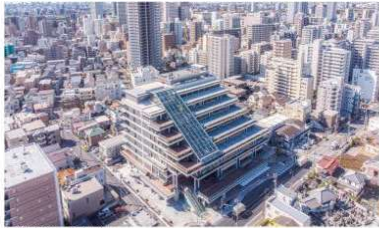
●新庁舎一期棟全景
